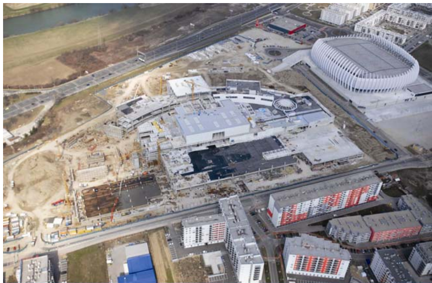
Gradilište u ožujku 2010.
