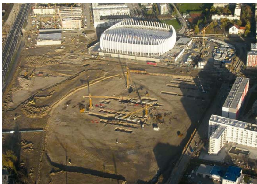
Početak radova u kolovozu 2008.
