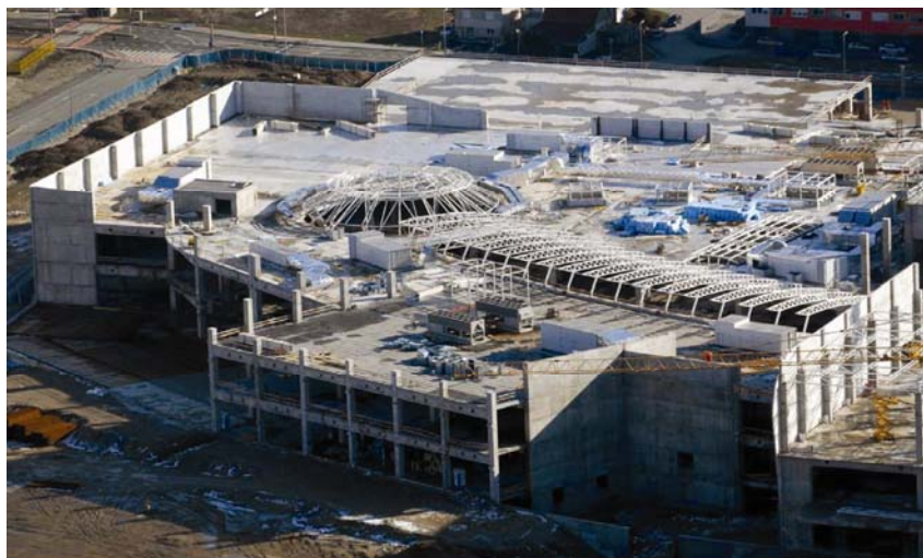
Spoj čelične krovne konstrukcije glavnog malla s prostorom zvanim Dalmacija
