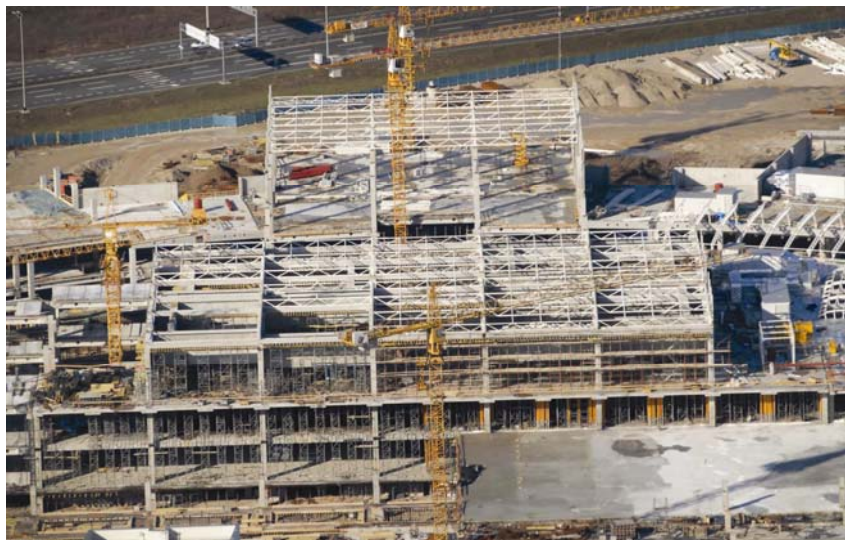
Izvedba krovne konstrukcije SineStar kina
