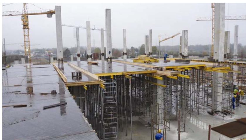
Izvedba naknadno prednapetih monolitnih armiranobetonskih ploča
