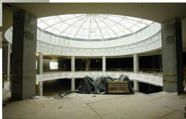
Završni radovi na prostoru zvanom Istra
