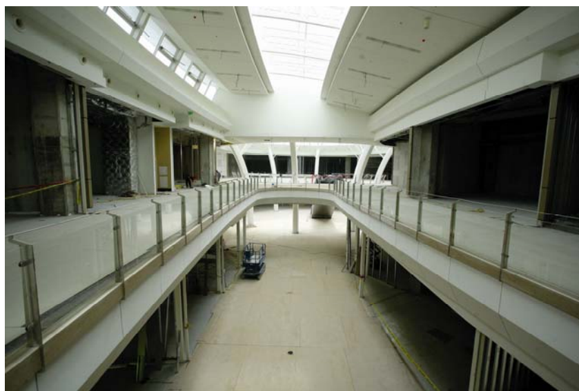
Dio glavnog malla pred završetkom
